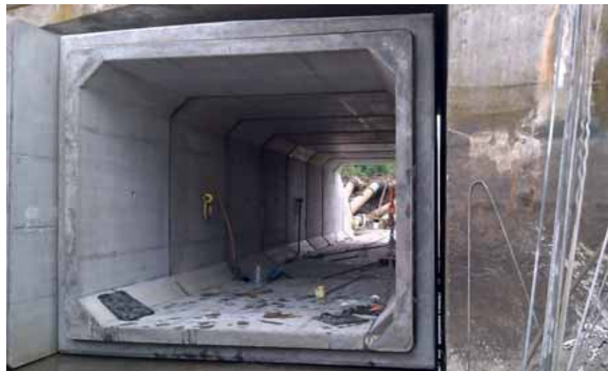
5. kép Keretelemek összehúzása belülről
