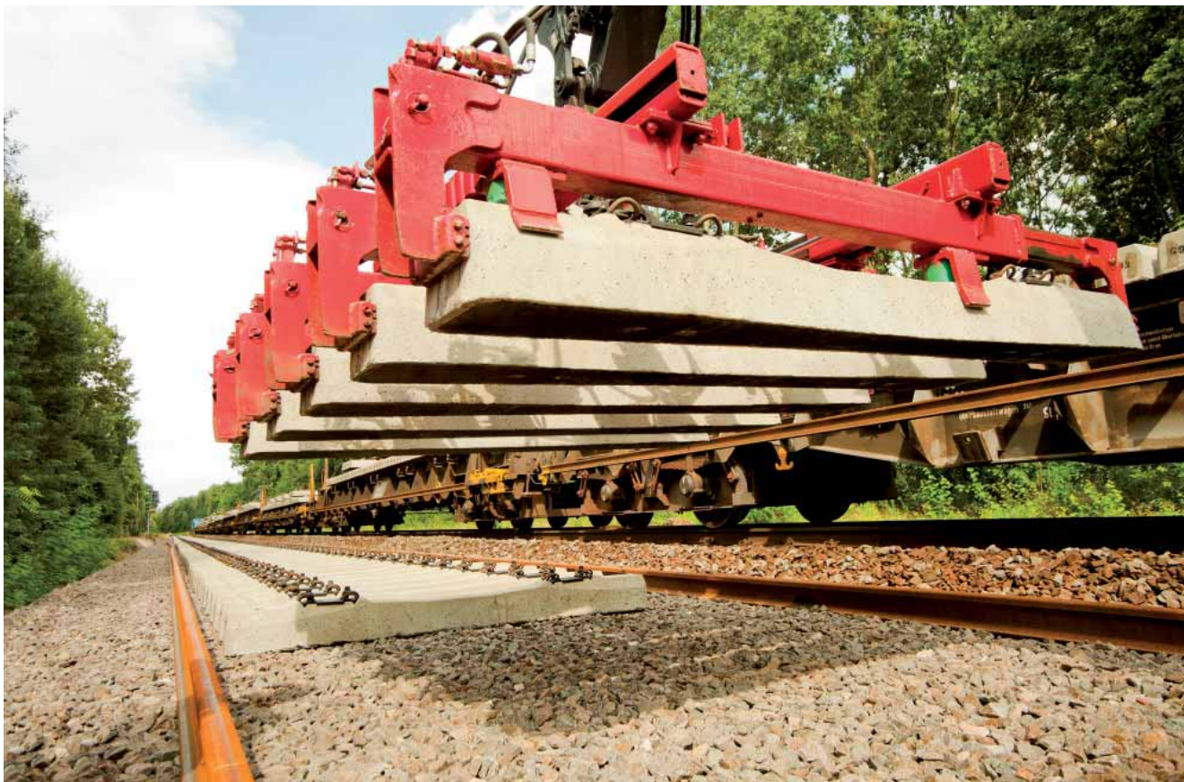
3. ábra Alul Sylomer® USP-vel ellátott vasbeton aljak telepítése
